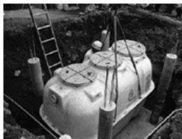
浄化槽設置の様子
